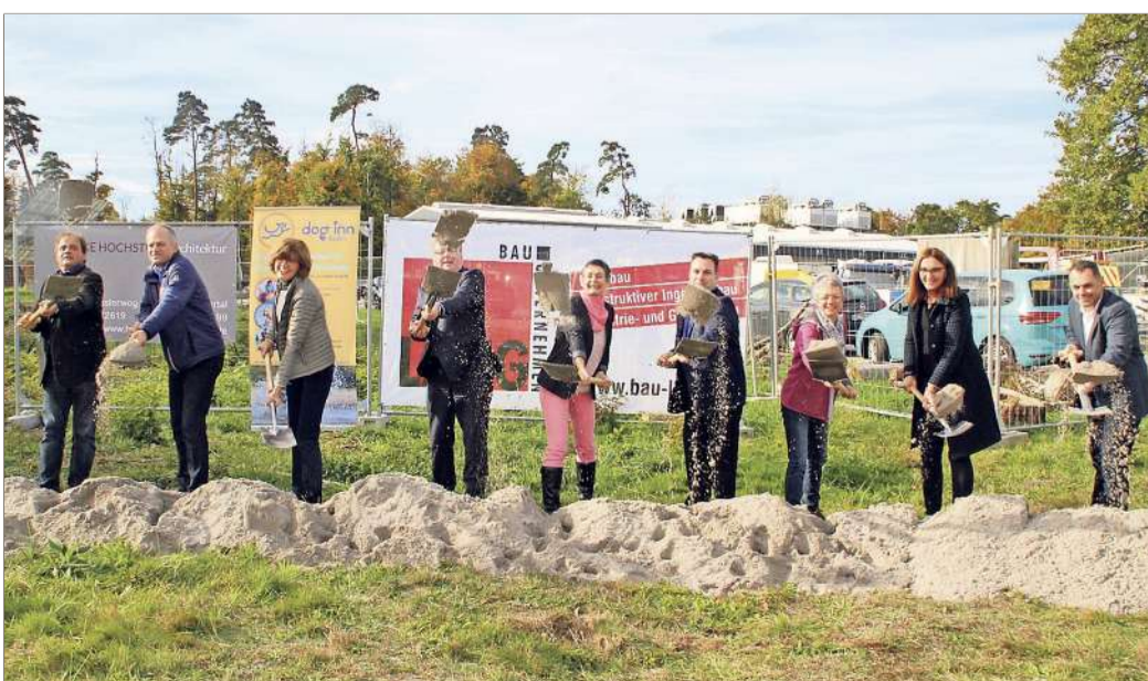
Die künftigen Betreiberinnen und Vertreter der beteiligten Firmen greifen zum Spaten, um damit den Start der Bauarbeiten für das Hundehallenschwimmbad zu symbolisieren. Foto: sie
